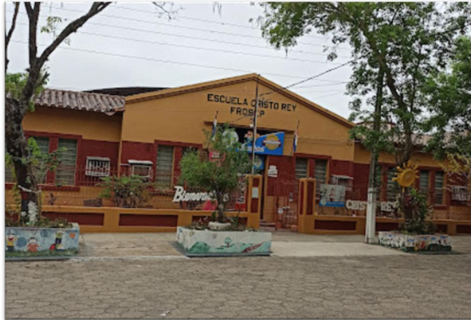
Figura 2 Fachada de la Escuela Básica N° 1140 Privada Subvencionada Cristo Rey FROSEP
